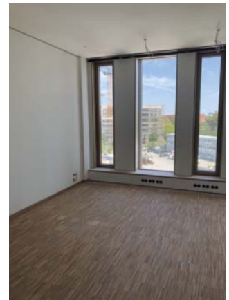
Blick in ein bereits nahezu fertig gestelltes Büro
